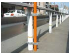
ガードレールポールに 親子バンド使用で固定
